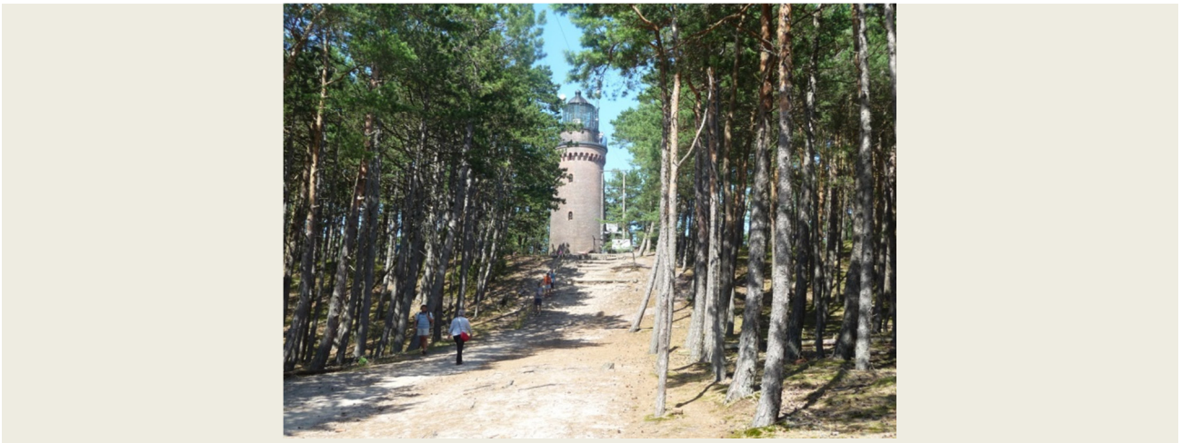
Scholpin: Weg zum Leuchtturm
