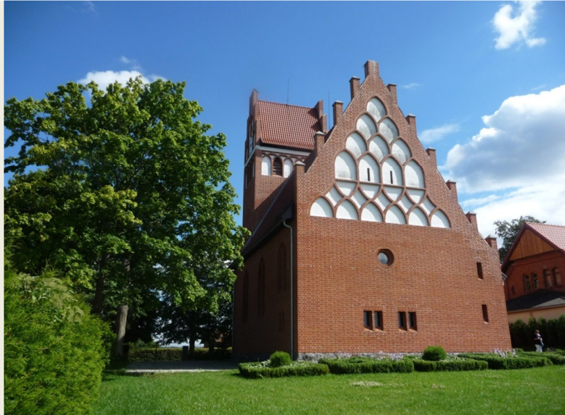
Frisch renovierte Dorfkirche in Weissunen
